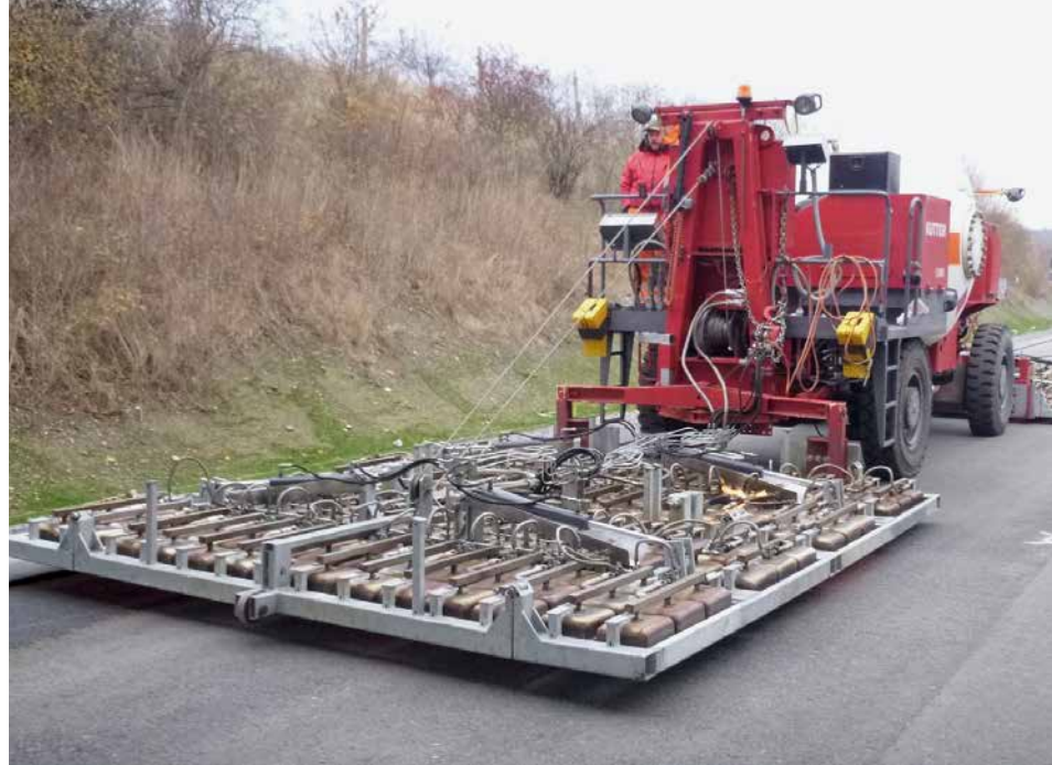
Zur Verbesserung der Einbaubrandbedingungen, wurde die Oberfläche der Asphaltbinderschicht vor dem Deckschichteinbau aufgeheizt
