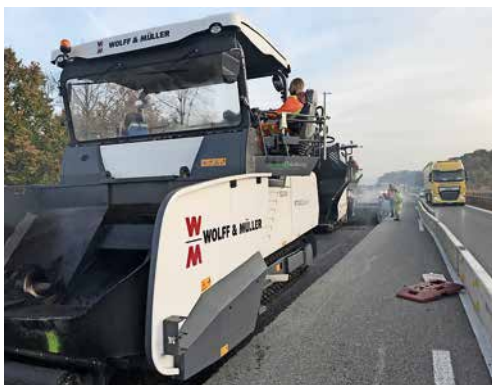
Mit Unterstützung einer 3D-Steuerung für den Fertiger wird die Straße profil- und spurgenaue
