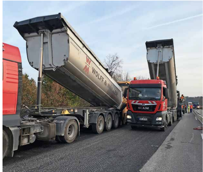
Ein Echtzeitsystem richtet alle Abläufe konsequent auf die wichtigste Maschine aus: den Straßenfertiger
