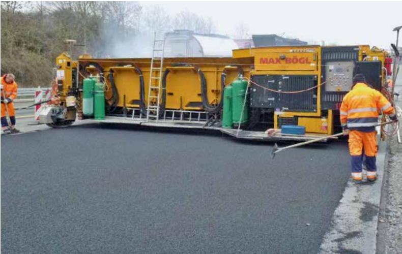
Der Einbau konnte über die gesamte Fahrbahnbreite erfolgen
