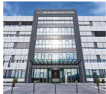
Auf 5 Etagen und 12.000 m 2 kommt das neue Verwaltungsgebäude
