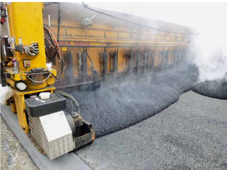
Insgesamt wurden auf einer Gesamtfläche von 125.000 m 2 Gussasphalt verlegt
