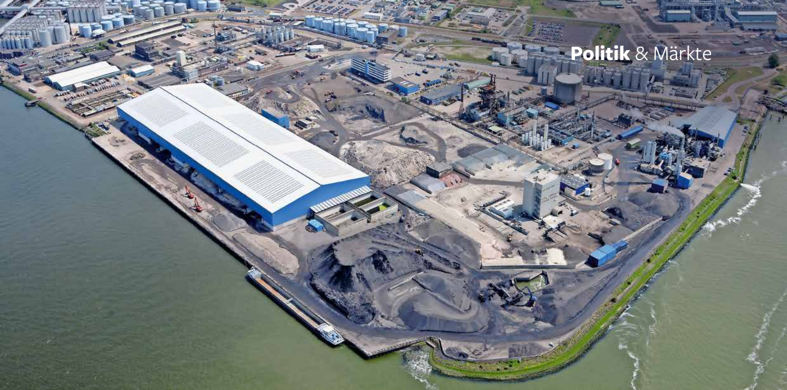
Wird um eine weitere Anlage erweitert: die Teeraufbereitung im Rotterdamer Hafen
