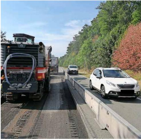
Bild 2: Mehr Schutz der Beschäftigten durch eine transportable Schutzeinrichtung anstelle von Baken
