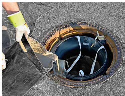
Ringspalten werden mit Vergussmörtel verfüllt, die in unterschiedlichen Körnungen zur Verfügung stehen
