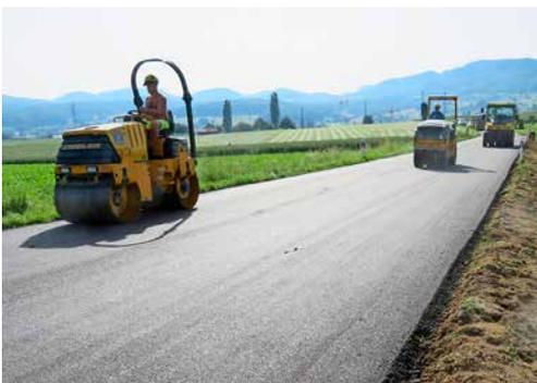
Bild 5: Fertig eingebaute Schicht aus Recyclingmaterial
