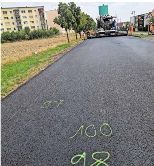
Bild 3: Entwicklung der Verdichtung nach 3 Walzüber-gängen mit Vibration auf der linken Fahrbahnseite
