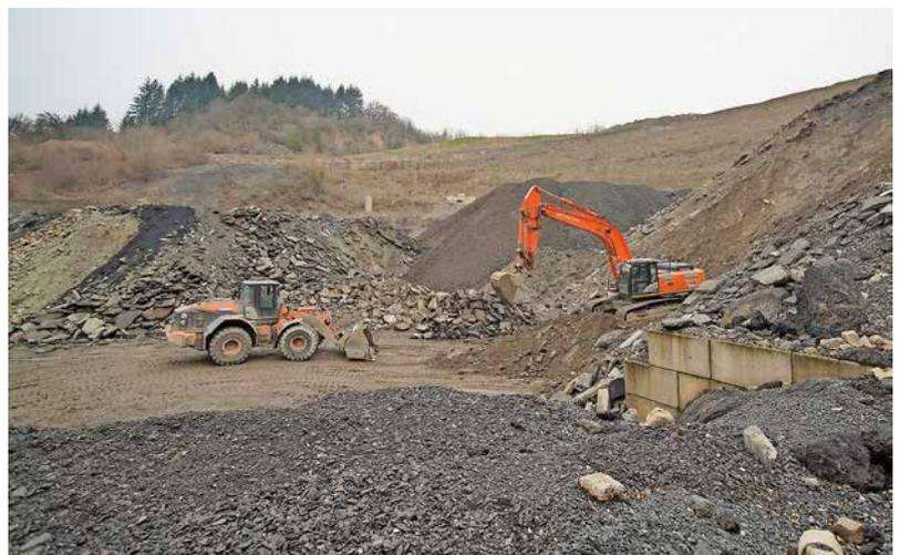
Insgesamt rund 40.000 t Ausbauasphalt, Beton-Aufbruch und Bauschutt fasst das Jost-Zwischenlager direkt oberhalb der Recycling-Anlage
