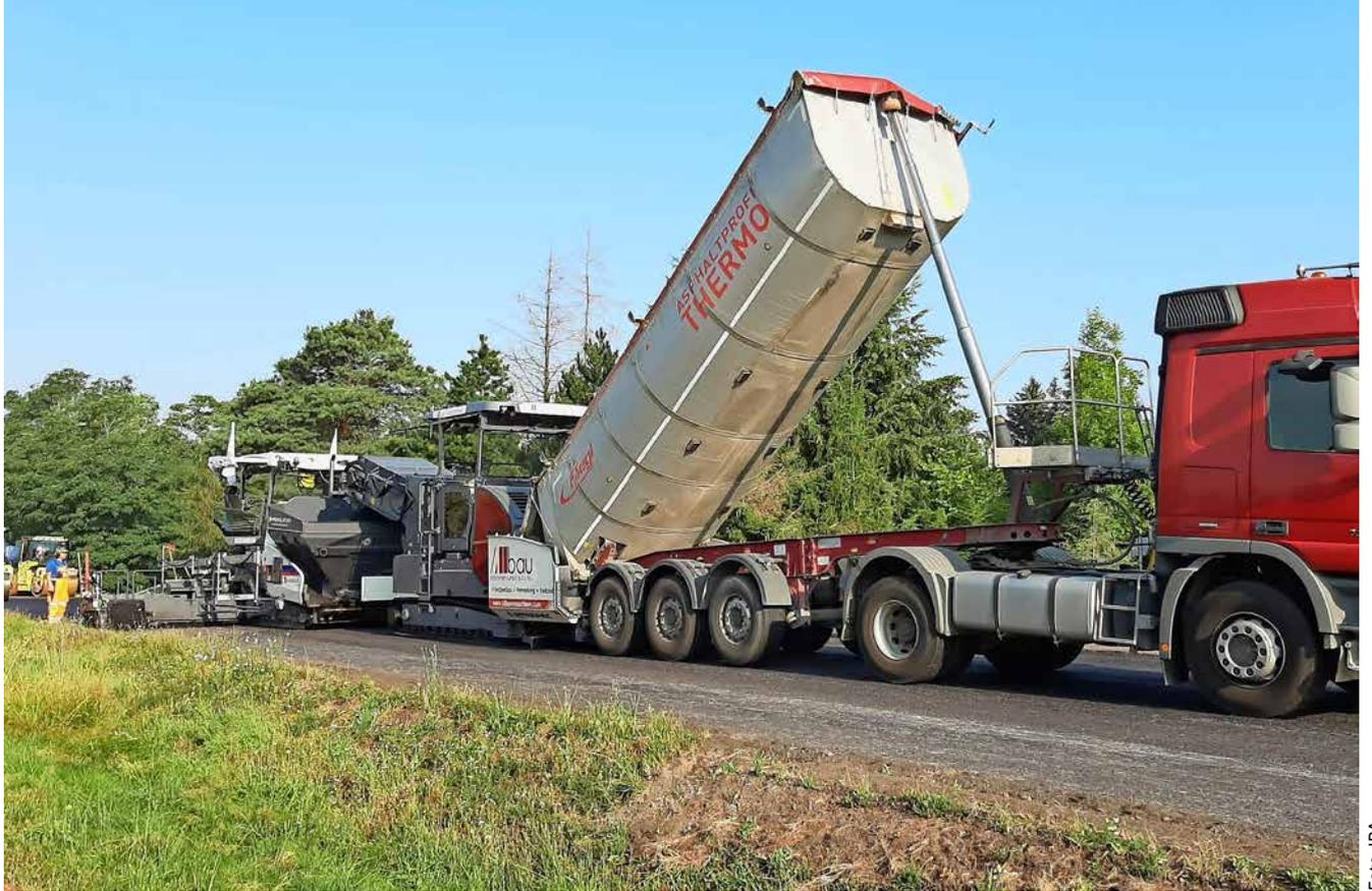
Einbau des temperaturabgesenkten Asphalt
