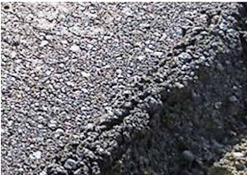
Bild 4: Kantenabbrüche aufgrund mangelnder Schulterstabilität
