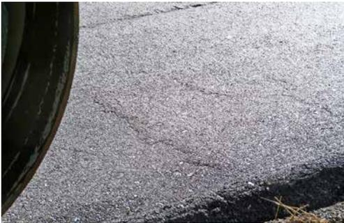
Bild 3: Durch Walze hervorgerufene Querrisse
