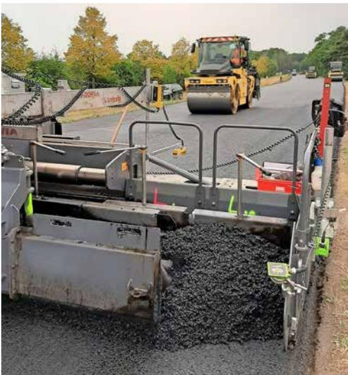
Bild 2: Verdichtung mittels unterschiedlicher Walzen
