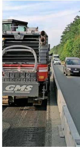
Bild 3: Fräsen entgegen der Fahrtrichtung
