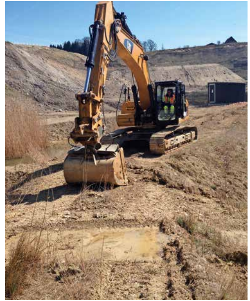
Mit dem Bagger werden Gewässer gebaut.
