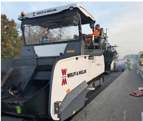
Profil- und spurgenau dank 3D-Steuerung am Fertiger.
