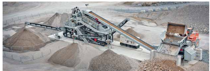
Waschen und Abwasseraufbereitung
